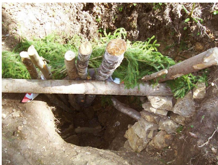
Вход в Паранойю с двухуровневым перекрытием и диагонально-поперечными распорами. Возможно, столь мощный крепёж — тоже своего рода паранойя... для тех, кто не копал этот шурф.
